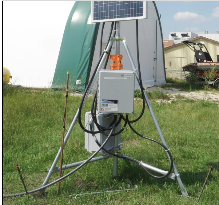
Figure 10. Tripode avec boîtier de l'enregistreur installé au-dessus du boîtier de batterie au bas de l'installation
