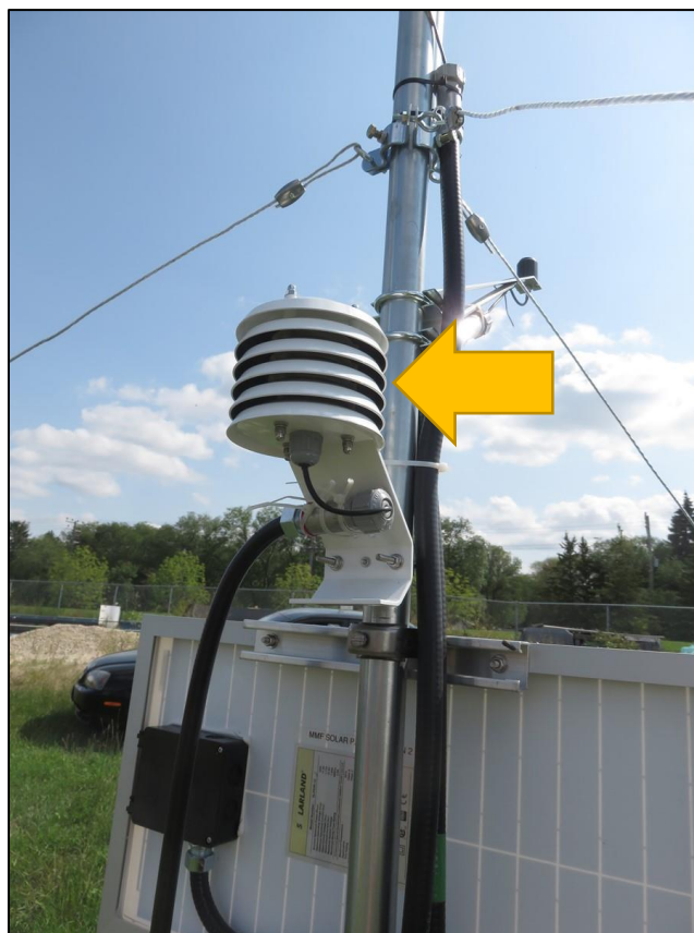
Figure 7. Boîtier du capteur de température et d'humidité relative (flèche jaune) placé du côté nord du mât, à l'opposé du capteur RPA et au-dessus du panneau solaire
